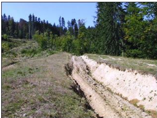
Fig. 2. Procese de ravenație pe un drum forestier din Poiana Slătioarei.
